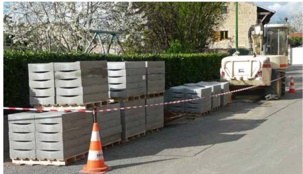
Après l'enfouissement des réseaux aériens, l'entreprise Eiffage Travaux Publics Est, adjudicataire du marché de travaux pour le remplacement des canalisations d'eaux pluviales et la pose de caniveaux, a démarré le chantier d'aménagement de la rue de la Fontaine le 28 mars 2011.
